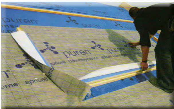
Pokládka nadkrokovního zateplení šikmé strechy
