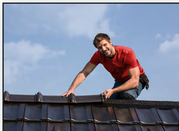
Montáž drážkového hrebenáča s vetracím pásom
