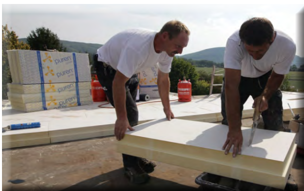
Pokládka PIR izolace na ploché střeše
