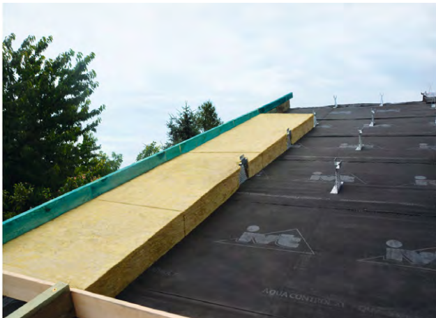
Systém Toprock – nadkroková izolácia medzi kovovými držiakmi
