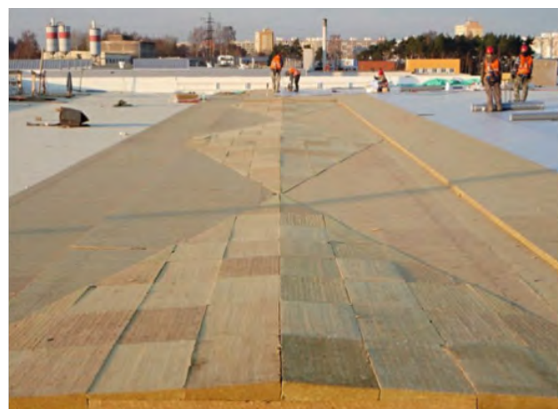
Odvodnenie plochej strechy – systém Rockfall
