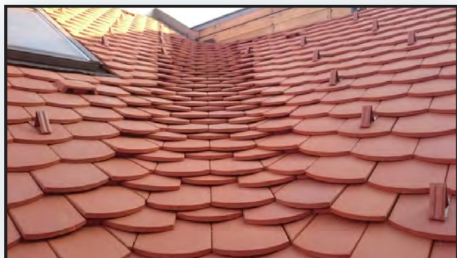
Detail vyskladaného úžlabia so škridlou Tondach Bobrovka
