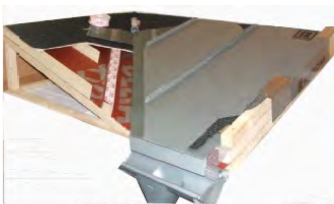
Obr. 23: Detail vyhotovenia oplechovania úžľabia, sklon < 10^\circ , drážkovaná krytina
