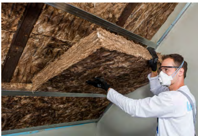
Šikmá strecha - izolácia medzi a pod krokami do SDK roštu
