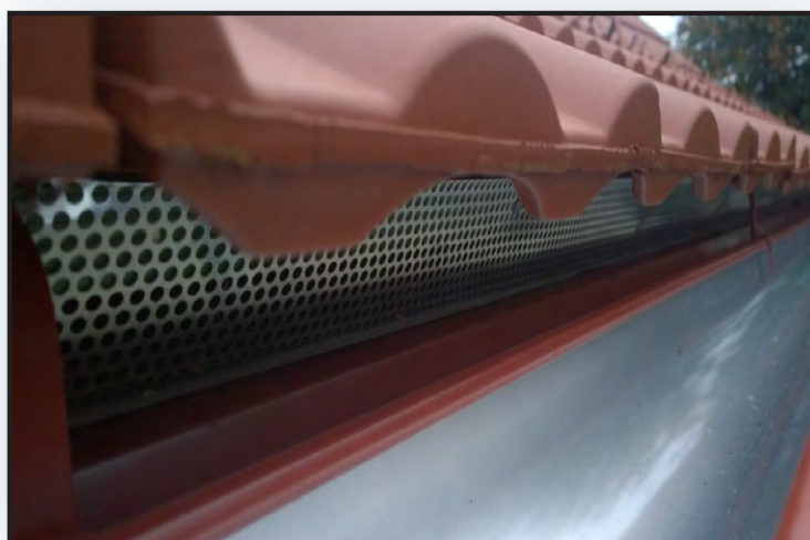
Detail odkvapu so škridlou Tondach Twist
