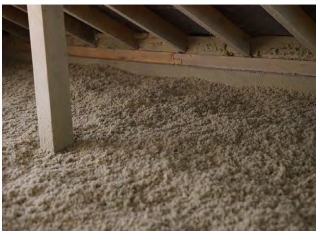
Fúkaná izolácia z granulovanej kamennej vlny
