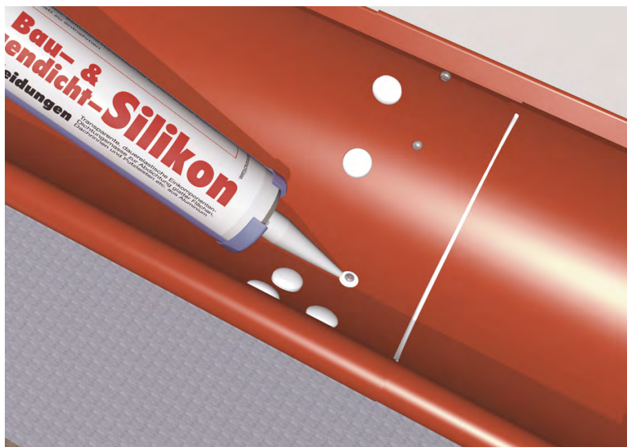
Obr. 12: Nitované spoje na vnútornej strane žľabu je nutné utesniť.
