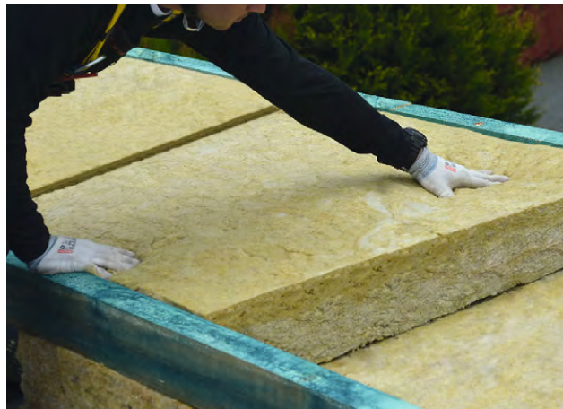
Systém Toprock – nadkroková izolácia medzi kovovými držiakmi
